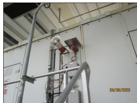
รูปที่ 3-26 Acoustic Alarm System
