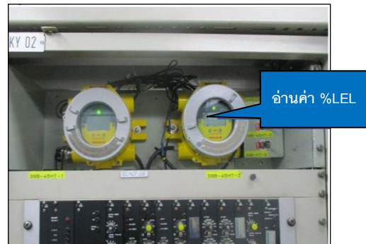
รูปที่ 3-45 Gas Detector Monitoring
