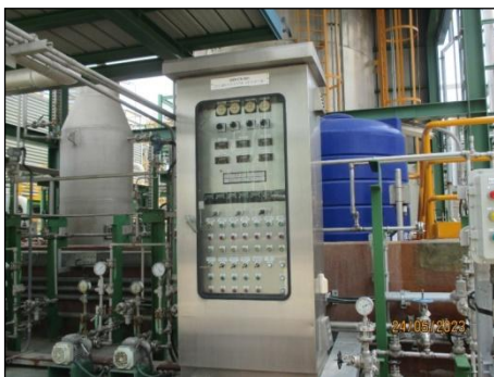
รูปที่ 3-32 การควบคุมสารละลาย แอมโมเนียมไฮดรอกไซด์ ด้วย DCS
