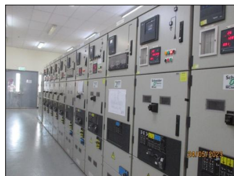
รูปที่ 3-19 ระบบ Remote Isolation
