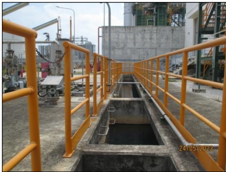
รูปที่ 3-8 บ่อพักน้ำ (Sump) ก่อนที่จะสูบน้ำฝนไปยังระบบบำบัดน้ำเสีย
