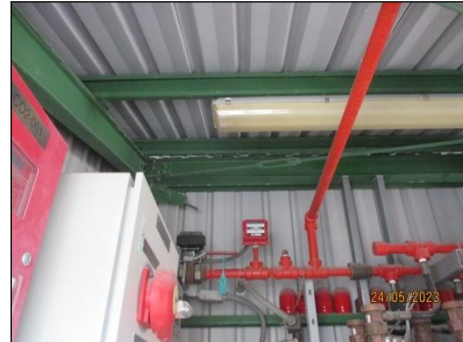
รูปที่ 3-39 Solenoid Valve CO 2
