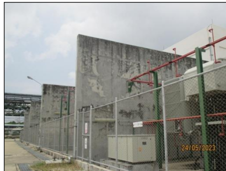
รูปที่ 3-21 ผนังกันไฟระหว่างหม้อแปลงไฟฟ้าแต่ละชุด
