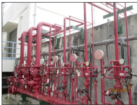
Deluge System บริเวณหม้อแปลงไฟฟ้า
