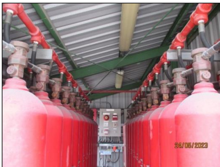
รูปที่ 3-40 Extinguisher Discharge System
