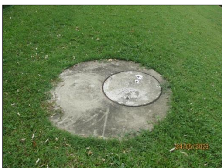
รูปที่ 3-6 Septic Tank
