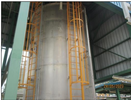
รูปที่ 3-30 ถังเก็บสารละลาย แอมโมเนียมไฮดรอกไซด์
