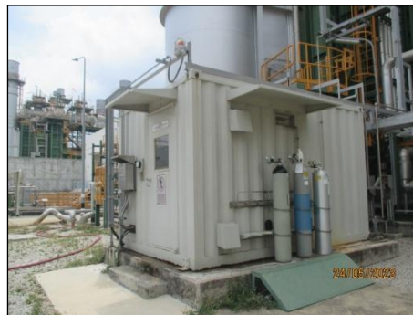
รูปที่ 3-1 ระบบการติดตามตรวจสอบคุณภาพอากาศจากปล่องระบายอากาศแบบต่อเนื่อง (CEMS)
