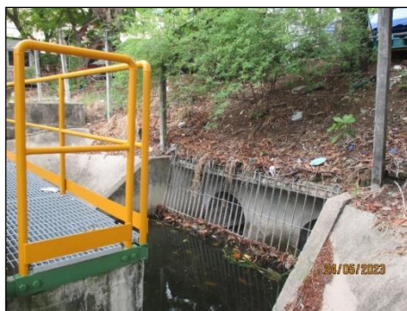
รูปที่ 3-16 ตะแกรงดักมูลฝอย
