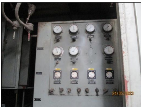
รูปที่ 3-42 ระบบ Pressure Monitoring
